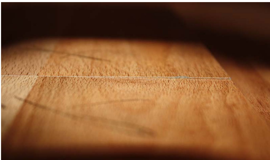
Bild 1 Überzahnung/ Kantenversatz zwischen 2 Laminat-elementen
