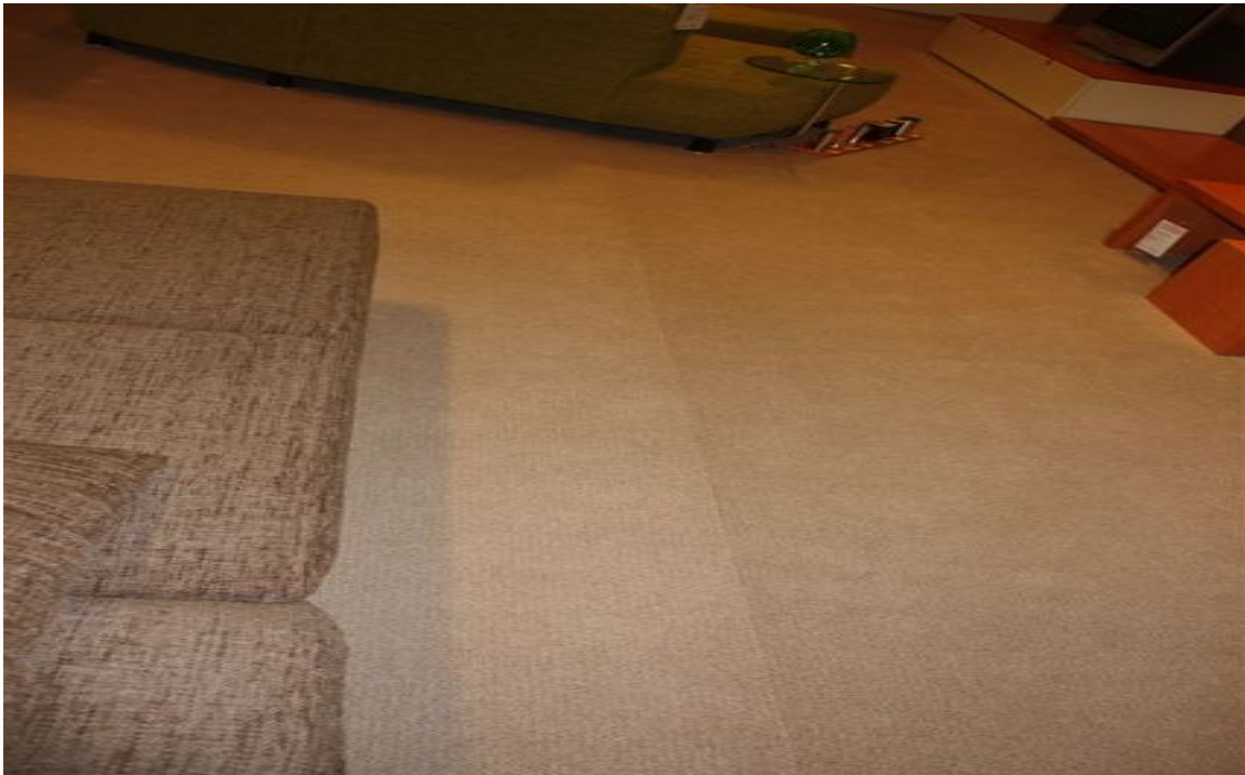
Bild 4, weitere Farbunterschiede der Teppichböden
