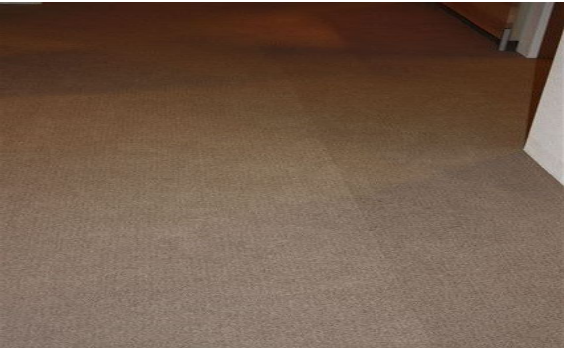
Bild 2, Farbunterschiede 2er Teppichbodenbahnen
