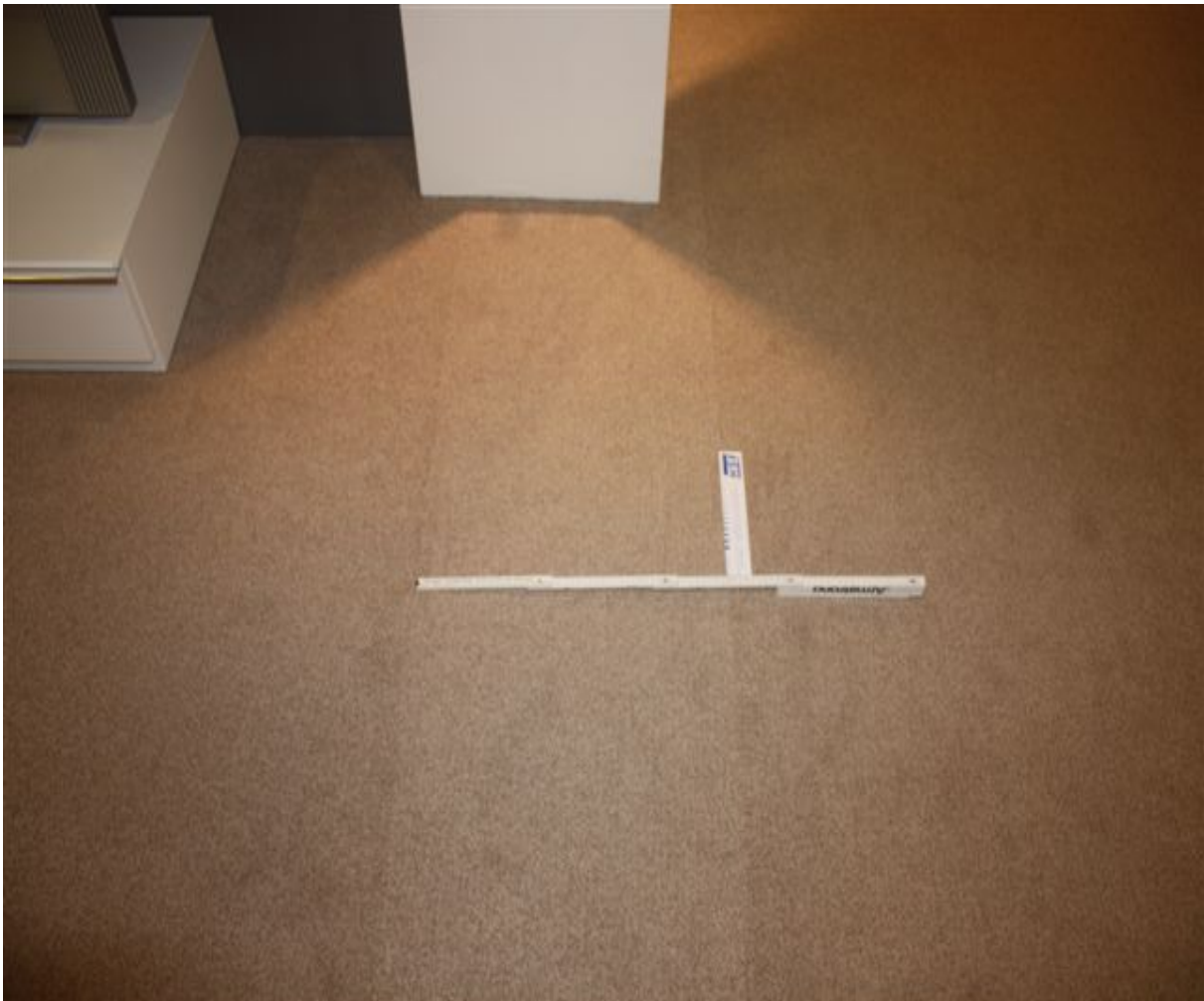
Bild 1, Farbunterschiede eines eingesetzten Teppichstreifens
